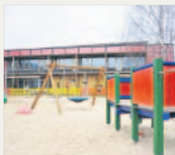
Schimmel: Im Mai soll die Kita Bummi saniert sein.
